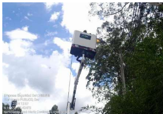
Fig. 10. Mantenimiento Tablazo - Aeropuerto
