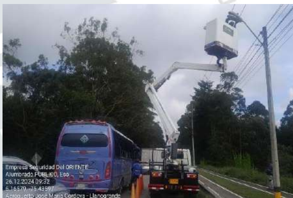
Fig. 9. Mantenimiento Tablazo - Aeropuerto
